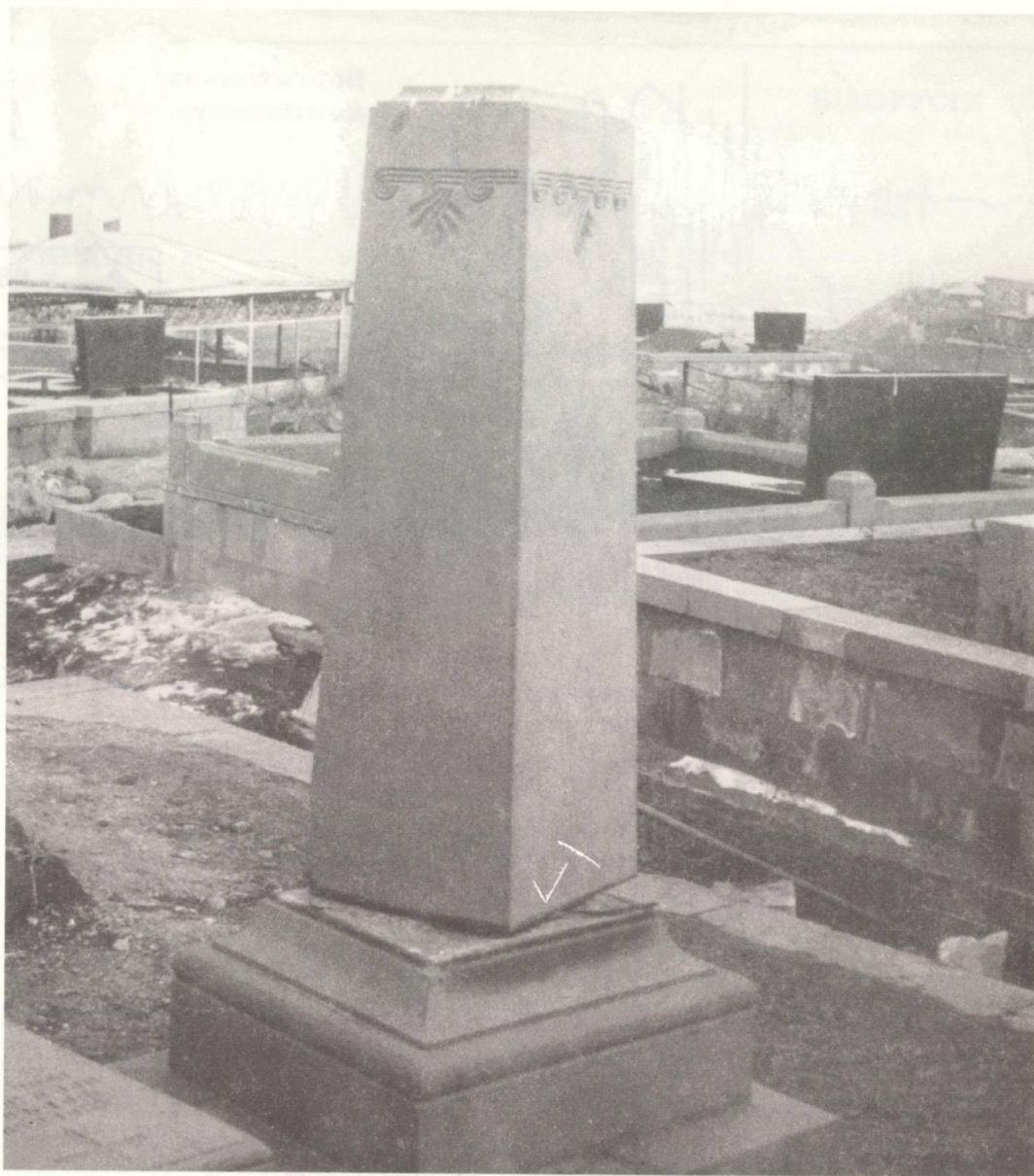
Рис. 1.15. Крутіння верхньої частини гранітного пам'ятника щодо нижньої під час Ташкентського землетрусу 1966 р.
